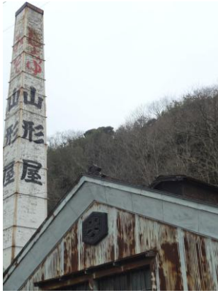
工場の機械が致命的損害を受けた(株)山形屋商店
